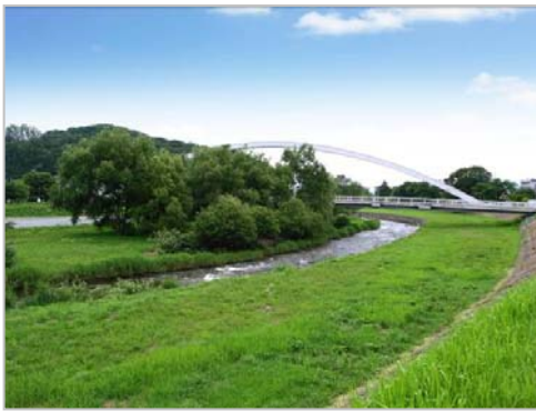
中津川橋上流
